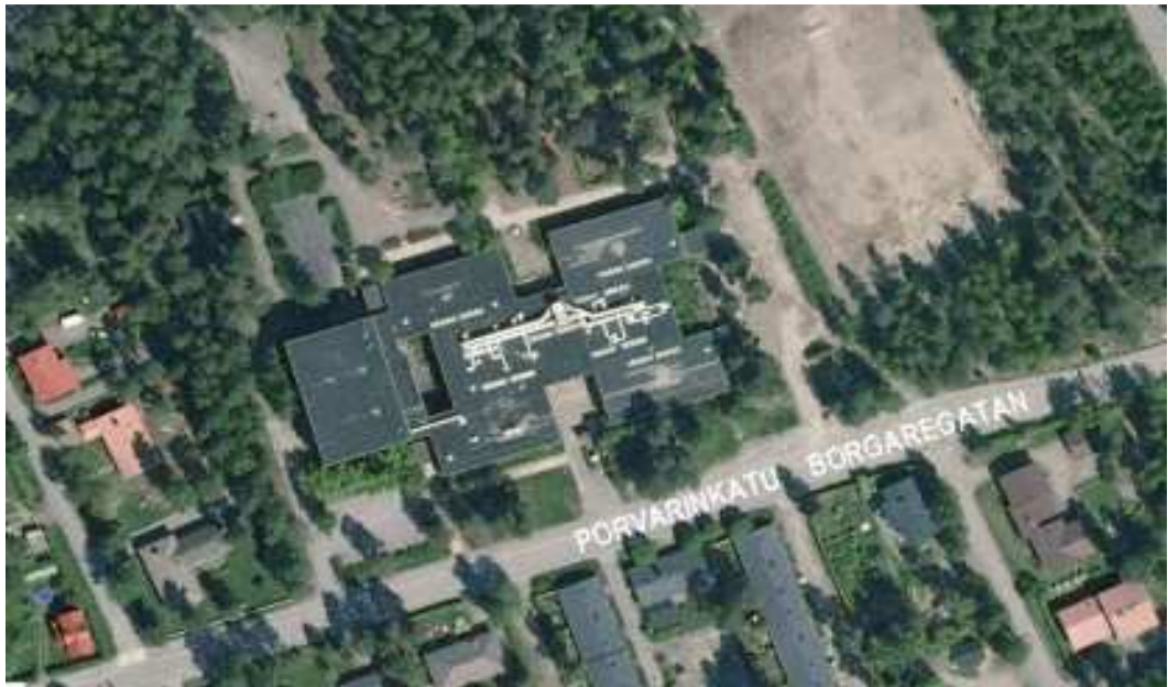
Kuva 4. Porvarinkadun koulun ilmakuva
